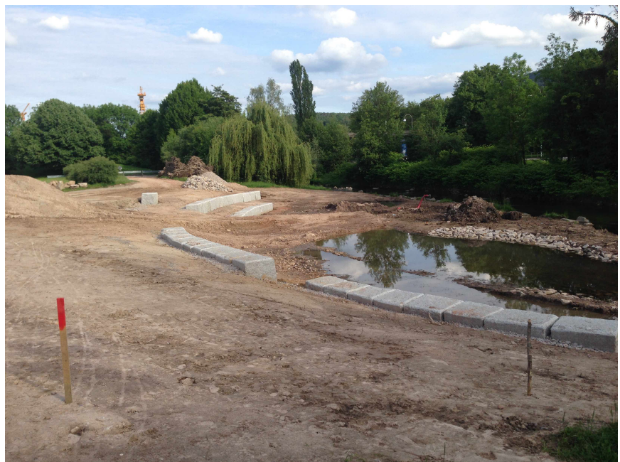
Neue Retentionsmulde an der Oos: Die Stadt nimmt im Wörthböschel für Hochwasserschutz und eine Aufwertung des Oosaue-Parks viel Geld in die Hand.
