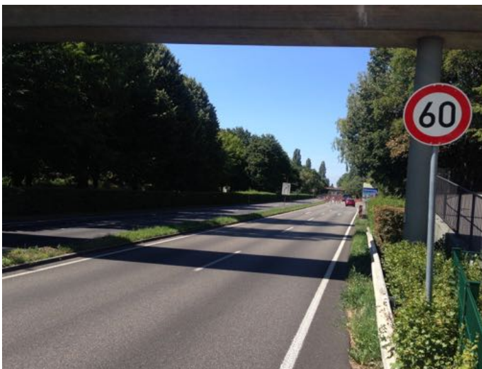
Widerspruch in der Argumentation von Oberbürgermeister Gerstner: An „Straßen mit V_{zul} > 50 km/h Schutzplanken grundsätzlich erforderlich“?
