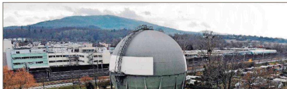
Der Gasbehälter an der B3 neu im Industriegebiet Oos-West ist Riedinger zufolge nicht dafür ausgelegt, größere Engpässe zu überbrücken. Dieser diene lediglich dazu, kurzfristige auftretende Verbrauchsspitzen abzudecken. „Die Kugel wäre in wenigen Stunden leer“, sagte Riedinger.
